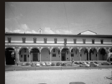
Hospital dos Expostos, Florença (fonte: CONNOR, ROBERTSON, 2002)
