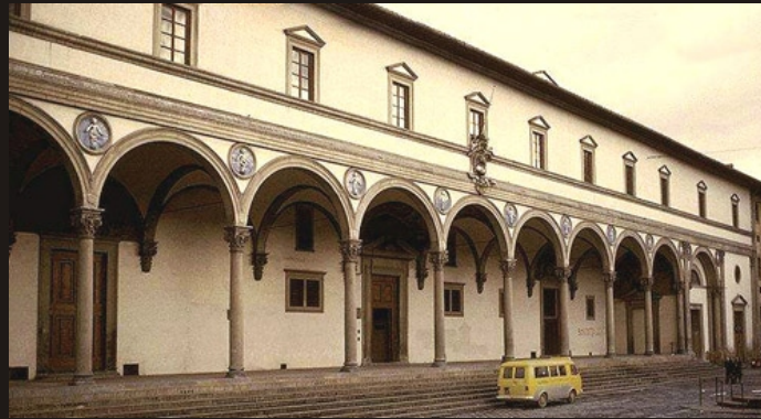
Hospital dos Expostos, Florença, 1419 (fonte: CONNOR, ROBERTSON, 2002)
